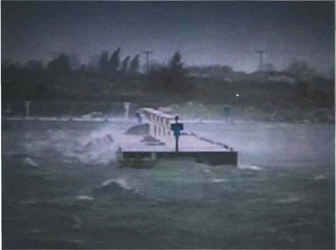
Drijvende golfbreker tijdens een storm windkracht 10 (bijna volledige demping van de golven)
