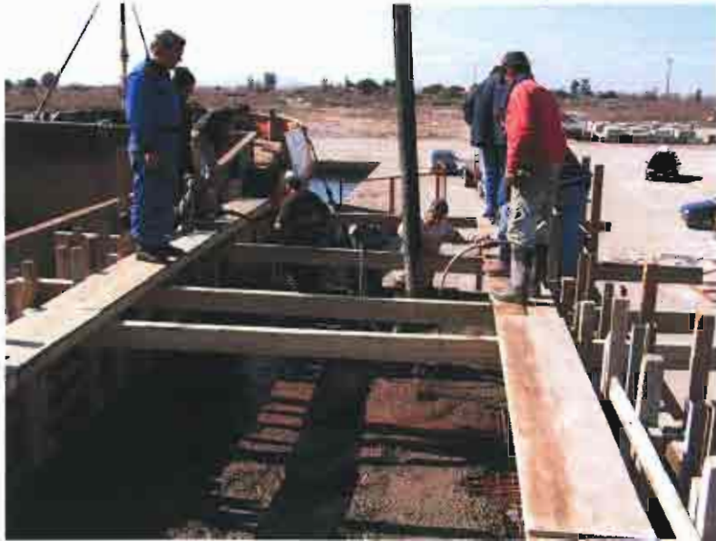
Storten beton op polystyrene blokken
