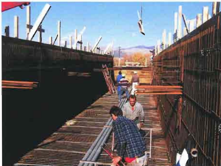
Vlechten van de wapening
