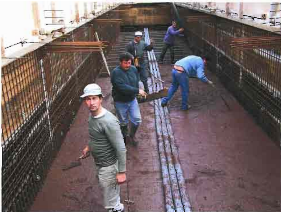
Storten van de bovenzvloer (elementen worden onderste boven gemaakt)
