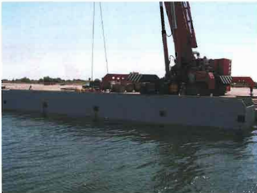
Plaatsen elementen 140 ton in het water
